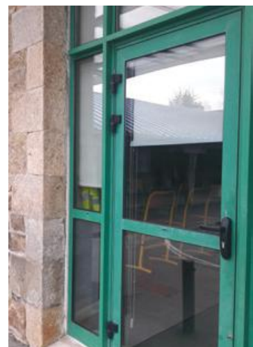
Stores sur les ouvertures à l'école
